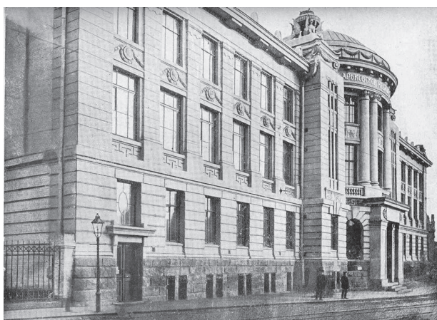
Грудень 1910 року. Палац Медицини — нова будівля Харківського Медичного Товариства, по вул. Пушкінська, 14 (сучасн. вул. Сковороди)
