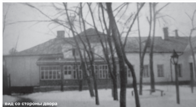
вид со стороны двора
