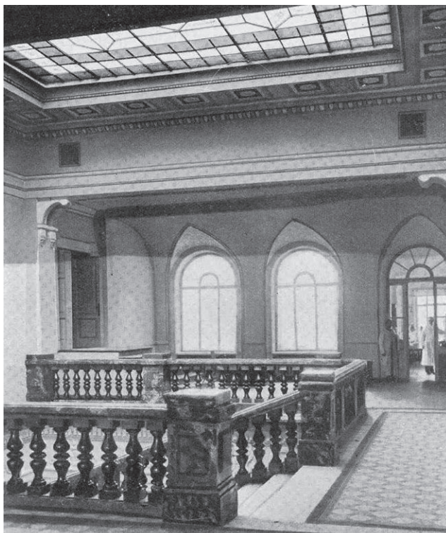
Інтер'єр Будівлі ХМТ. Третій поверх. Сходи, вестибюль, на задньому плані — вхід до лабораторії
